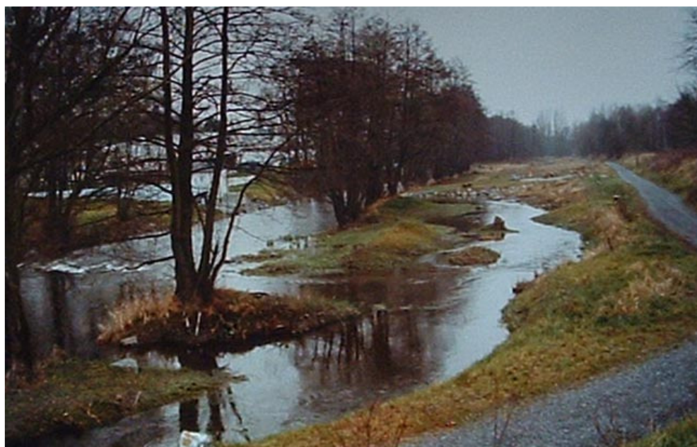
Foto 1 Zvýšení kapacity koryta regulovaných toků ve městě se spojí se zpřírodněním řeky, revitalizací nábřeží a prostoru mezihrází tak, aby se revitalizovaná řeka stala součástí života města, byla jeho významnou urbanistickou páteří, poskytovala možnost pro rekreaci a sport. Řeka Saale ve městě Hof, Bavorsko. Foto P. Štenclová
