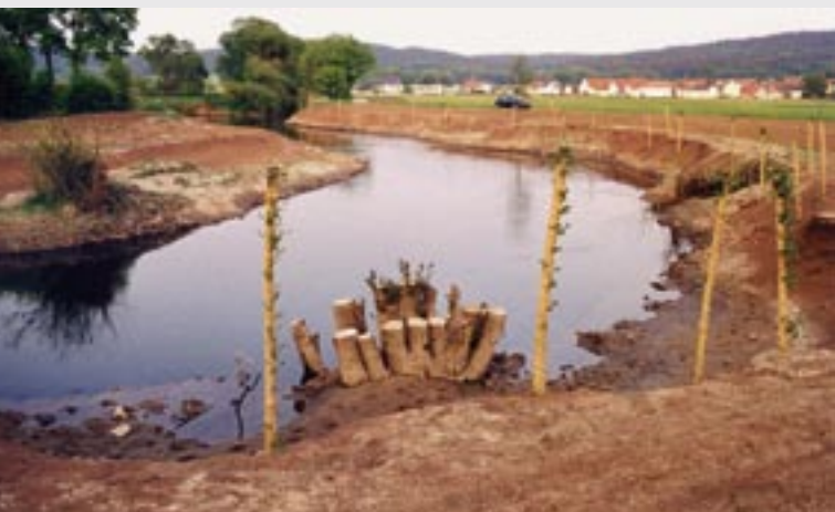
Obr. 2. Ukázka revitalizace řeky Itz u obce Gleusdorf, Bavorsko. Kromě zvětšení kapacity koryta a zpomalení odtoku se docílilo i funkčního spojení toku s nivou a retence povodňových vod v nivě.
