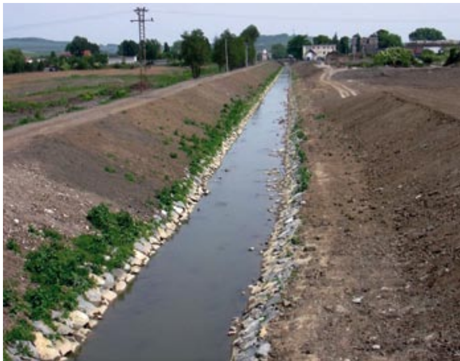
Obr. 1. Úprava koryta řeky Litavy v katastru města Slavkov u Brna. Celková délka této úpravy je 2429 m a má zajistit bezpečný průchod Q100.
