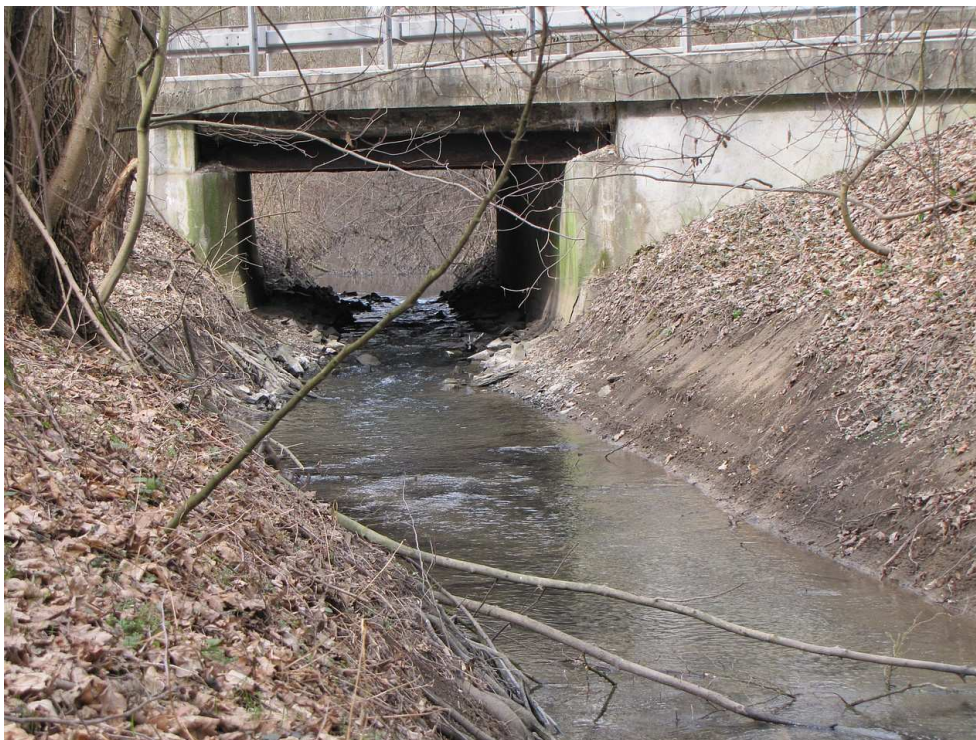
Obr. 22: Objekt mostu (silnice Pňovice - Střeň) - místo, kde by měly být dřevěné stabilizační prvky (dílčí akce 3)
