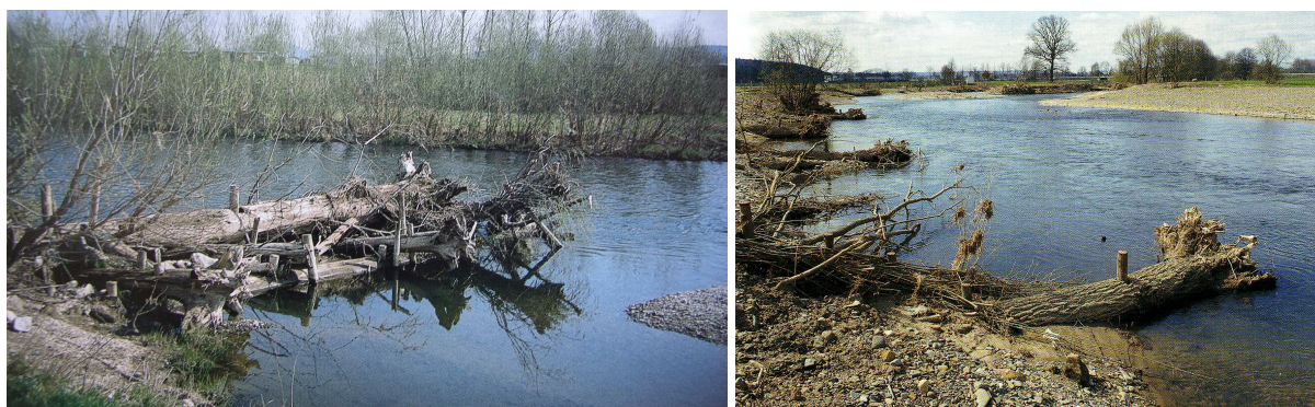
Obr. 1: Ukázka kotvení říčního dřeva pomocí dřevěných kůlů. Toto řešení je velice elegantní a trvanlivé. Řeka Mohan, Německo (převzato z: Just - Valentová, 2006).
