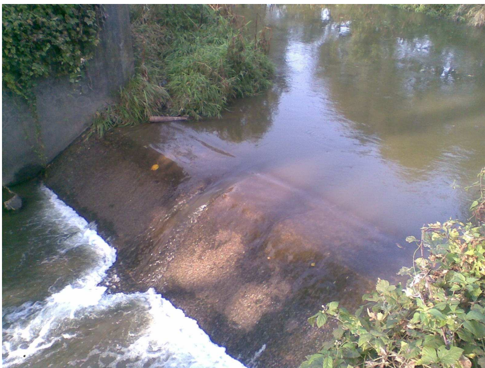
Obr. 23: Objekt bočního jezu Zamykalka - přelivnou hranu vodní paprsek přetéká jen výjimečně (dílčí akce 4)
