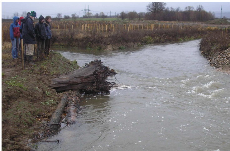
Obr. 4: Stabilizace břehu pod soutokem Moravské Sázavy a Lukovského potoka
