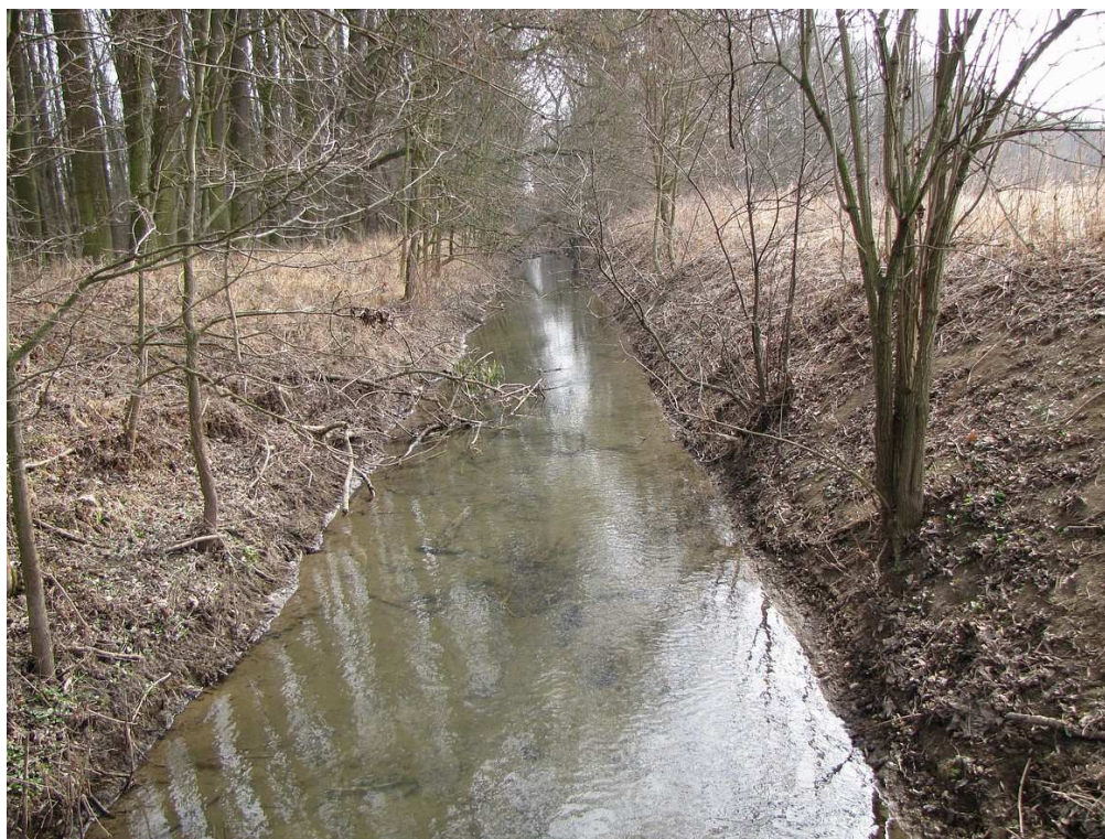
Obr. 21: Unifikované koryto toku Písečné v CHKO LP(dílčí akce 3)
