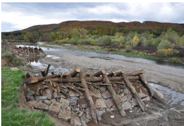
Bečva u Famílie – probíhající realizace bočních výhonů ze dřeva a kamene jako renaturalizačních opatření usměrňujících další korytotvorný vývoj toku a vytvářejících příznivé prostředí pro říční ryby (podpora vzniku tůň a tišin)
