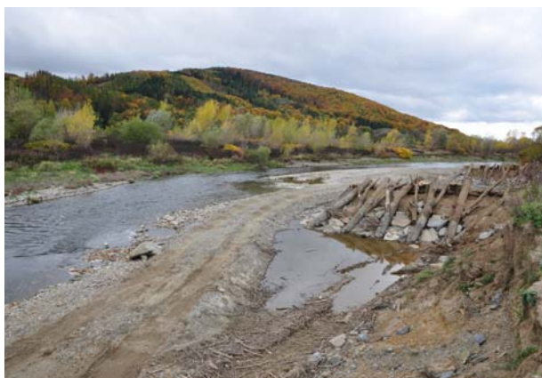
Bečva u Famílie – probíhající realizace bočních výhonů ze dřeva a kamene jako renaturalizačních opatření usměrňujících další korytotvorný vývoj toku a vytvářejících příznivé prostředí pro říční ryby (podpora vzniku tůň a tišin)
