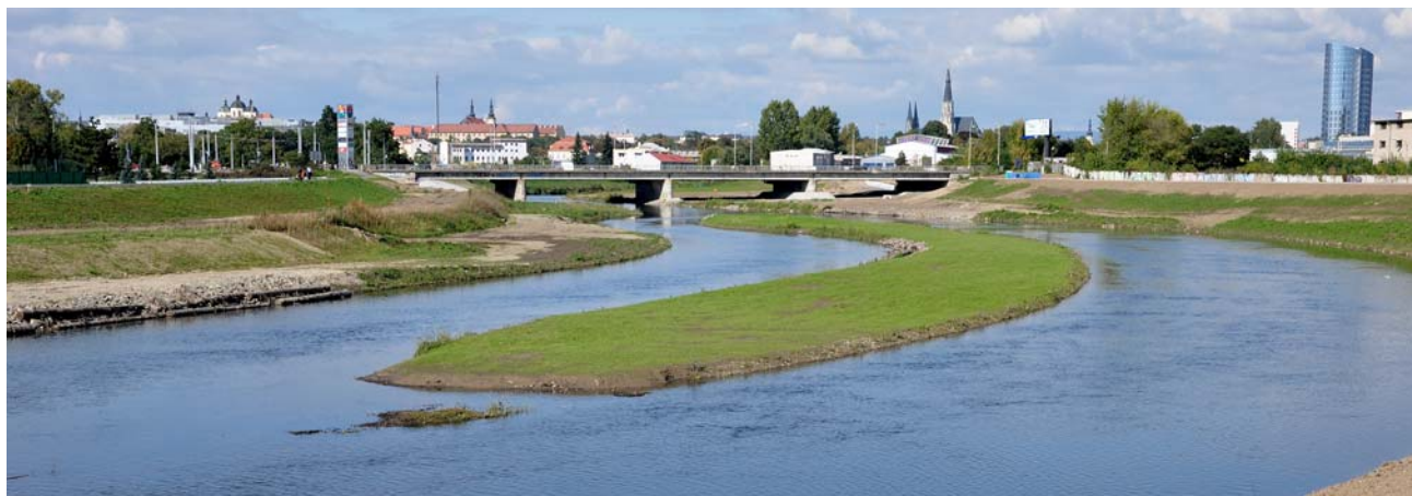
Technická revitalizační úprava řeky Moravy v Olomouci – ostrov, rozdvojení kynety, nižší a vyšší úroveň plochých břehů (tzv. berma). Stavebně vybudováno v rámci protipovodňových opatření. Záběr koryta před dokončením stavby a výsadbou břehových porostů
