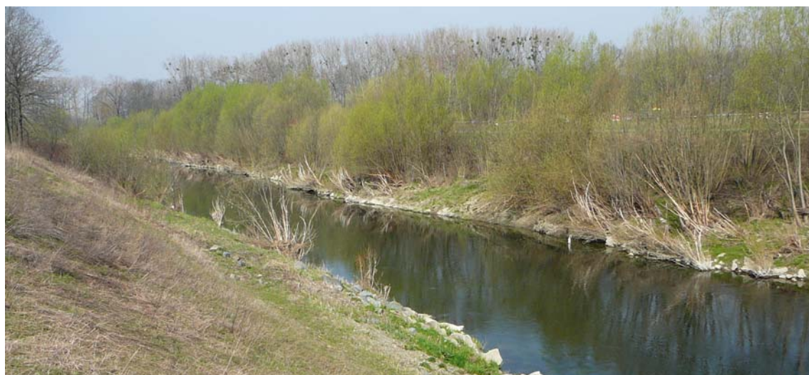
Bečva s regulovaným a dnovou erozí přehloubeným korytem. Porosty keřových vrb, které alespoň trochu oživují svahy břehů, bývají odstraňovány
