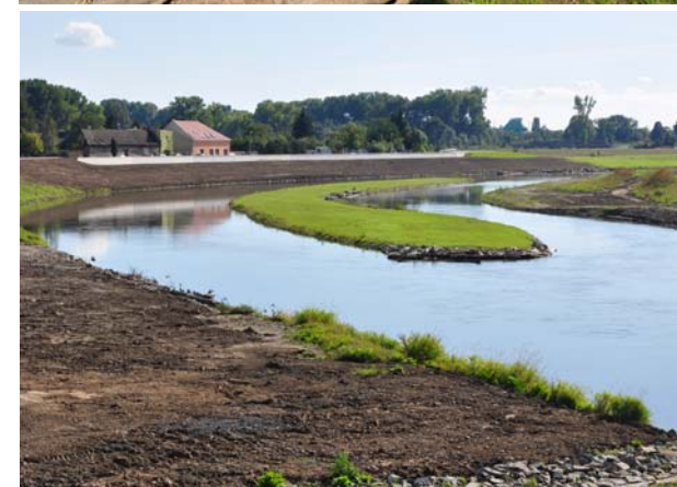
Morava v Olomouci – příklad stavebně-technické revitalizace toku jako součásti protipovodňových opatření. Biotechnické opevnění břehů z dřevní hmoty (kmeny stromů) vytváří úkryty pro ryby. Rozdvojení kynety a vytvoření ostrova zvyšuje stanovištní diverzitu prostředí
