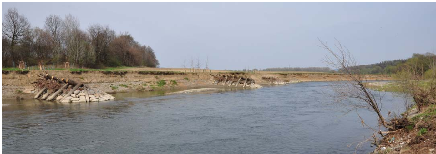
Bečva u Familie – břehové výhony ze dřeva a kamene jsou prvním renaturalizačním opatřením použitým v praxi na ochranu nemovitostí a umožnění usměrněného korytotvorného vývoje řeky
