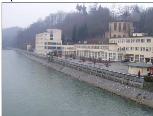
Obr. č. 64. – lokalita.č.131. – úsek toku u Teplíc
