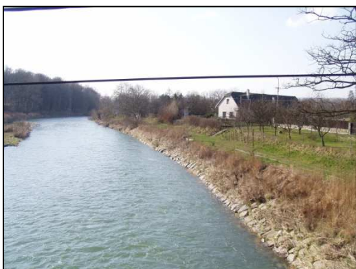
Obr.č. 51. – lokalita č.114. – úsek toku pod Hranicemi
