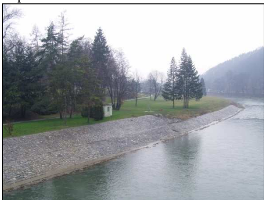
Obr.č.63. – lokalita č.131. – úsek toku u Teplíc
