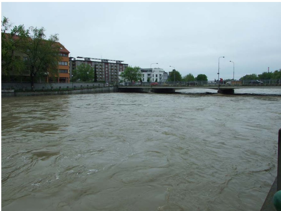
13 Silniční most v Přerově při povodni dne 18.5.2010, průtok Q = 594 \text{ m}^3\cdot\text{s}^{-1}
