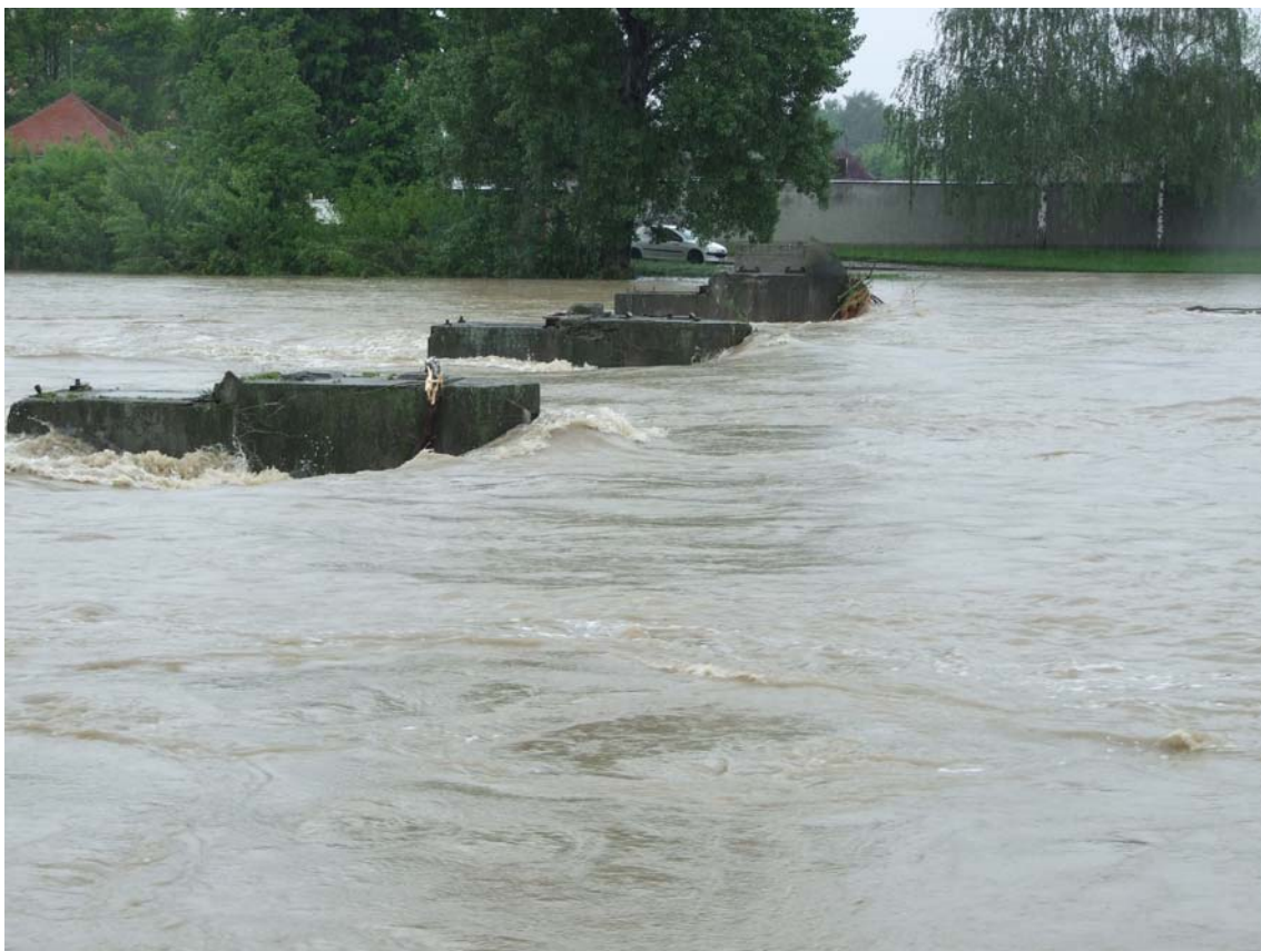
16 Pozůstatky pilířů dřívějšího jezu nad současným jezem v Přerově
