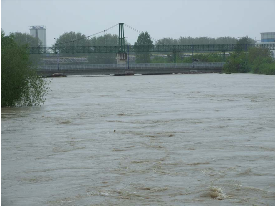
19 Most železniční vlečky při povodni dne 18.5.2010, průtok Q = 606 \text{ m}^3 \cdot \text{s}^{-1}
