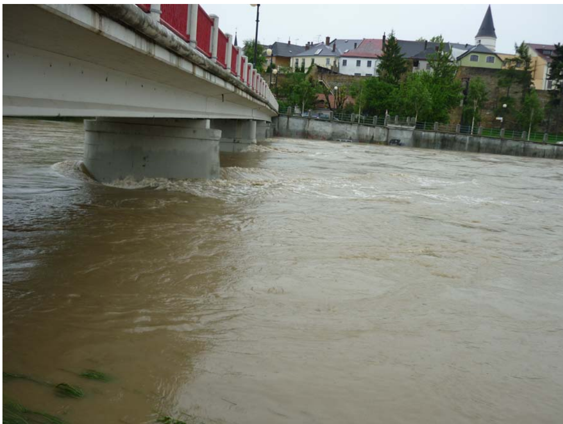
11 Lávka u hradeb v Přerově při povodni dne 18.5.2010, průtok Q = 594 \text{ m}^3\cdot\text{s}^{-1}
