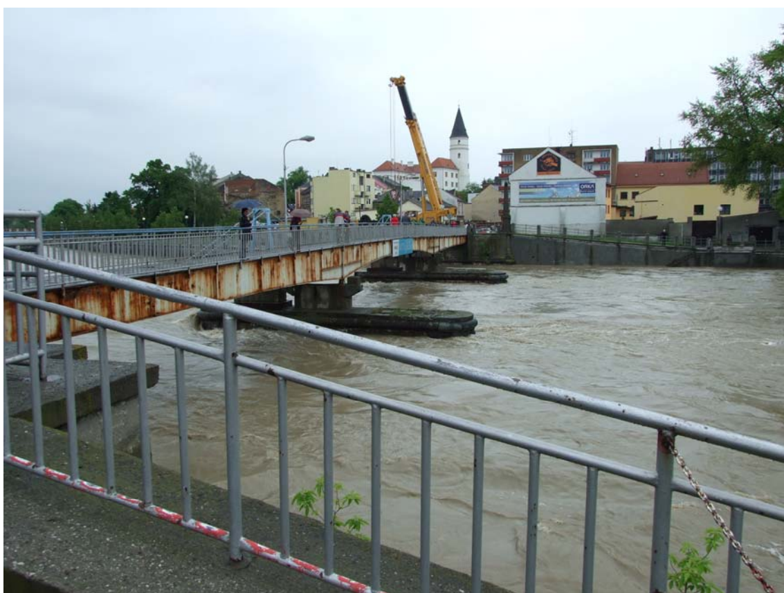
12 Pilíře lávky u sokolovny v Přerově při povodni dne 18.5.2010, průtok Q = 594 \text{ m}^3\cdot\text{s}^{-1}
