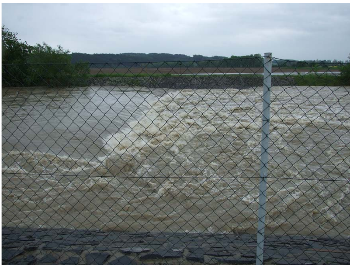
8 Stupeň Osek při povodni dne 18.5.2010, průtok Q = 410 \text{ m}^3 \cdot \text{s}^{-1}
