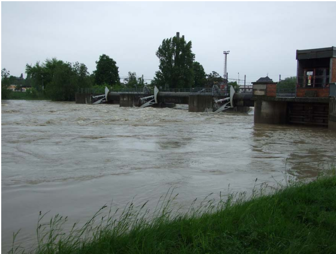
17 Jez Pšov při povodni dne 18.5.2010, průtok Q = 615 \text{ m}^3 \cdot \text{s}^{-1}
