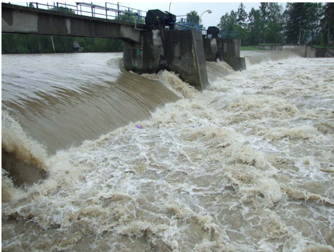
7 Jez Osek při povodni dne 18.5.2010, průtok Q = 408 \text{ m}^3 \cdot \text{s}^{-1} , v popředí nefunkční rybochod
