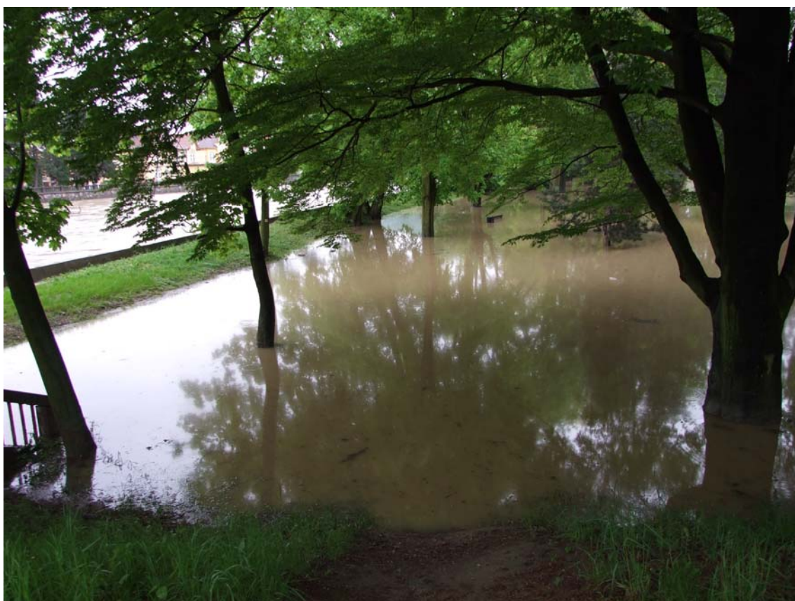
4 Zemní hráz s betonovou zídkou na levém břehu v Sadu Čs. legií v Hranicích
