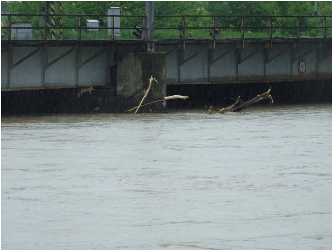
15 Železniční most v Přerově při povodni dne 18.5.2010, průtok Q = 600 \text{ m}^3 \cdot \text{s}^{-1}
