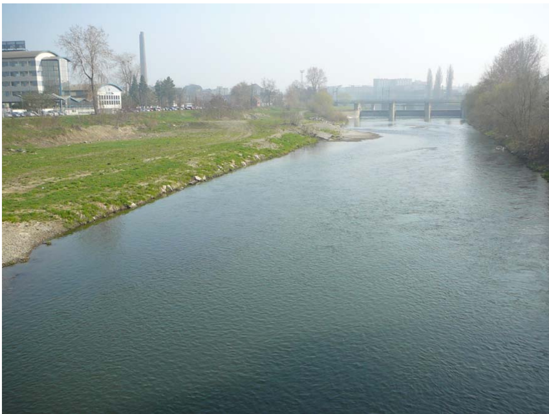
18 Pravoběžní berma po živelné těžbě mezi jezem a vlečkovým mostem v Pšově
