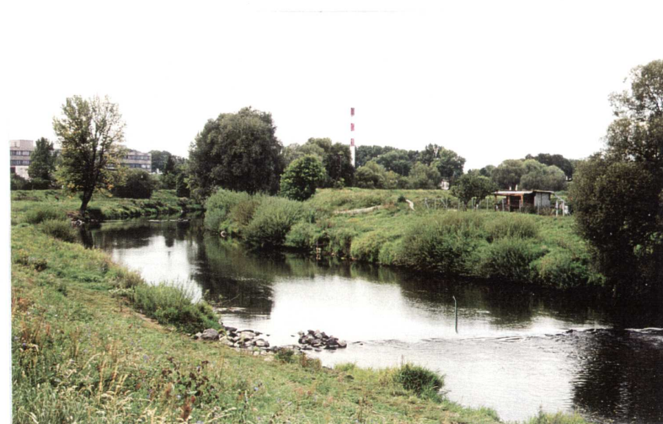
nad ocelovou lávkou km 236,00
