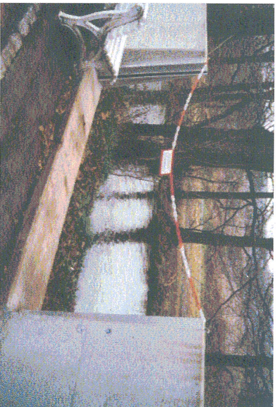
Průmyslový areál u řeky je chráněn protipovodňovou stěnou z betonu s uzavíratelnými vstupy (Foto P. Šenclová)
