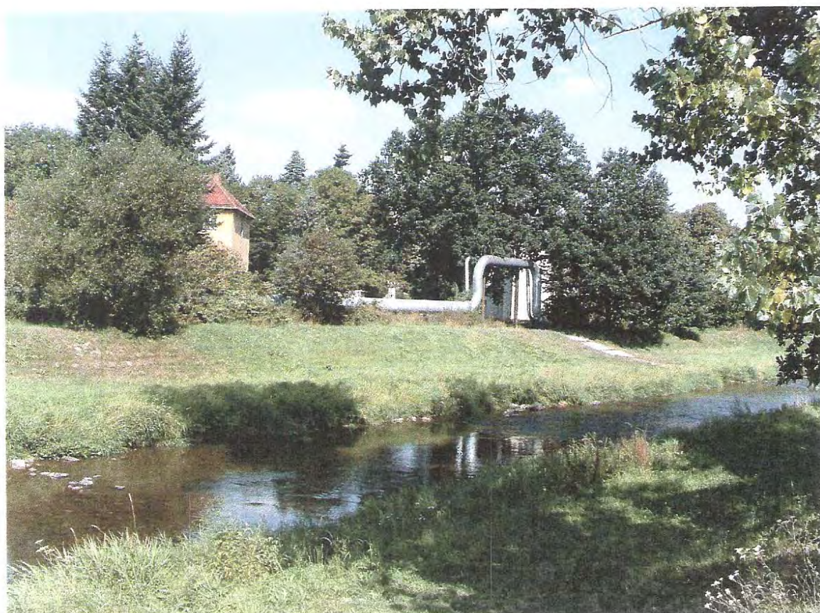
Obr. 10 Řeka Opava pod mostem Vrchlického
