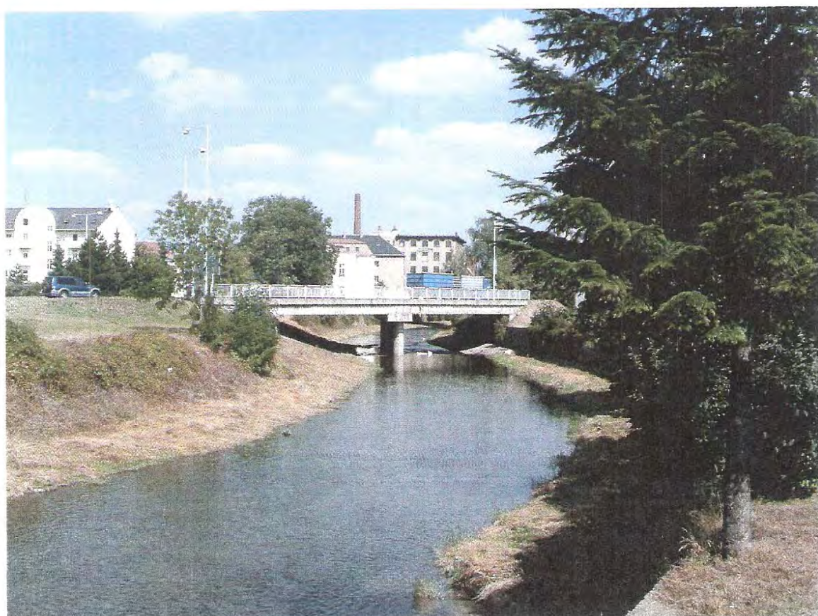
Obr. 6 Řeka Opava nad mostem Opavská
