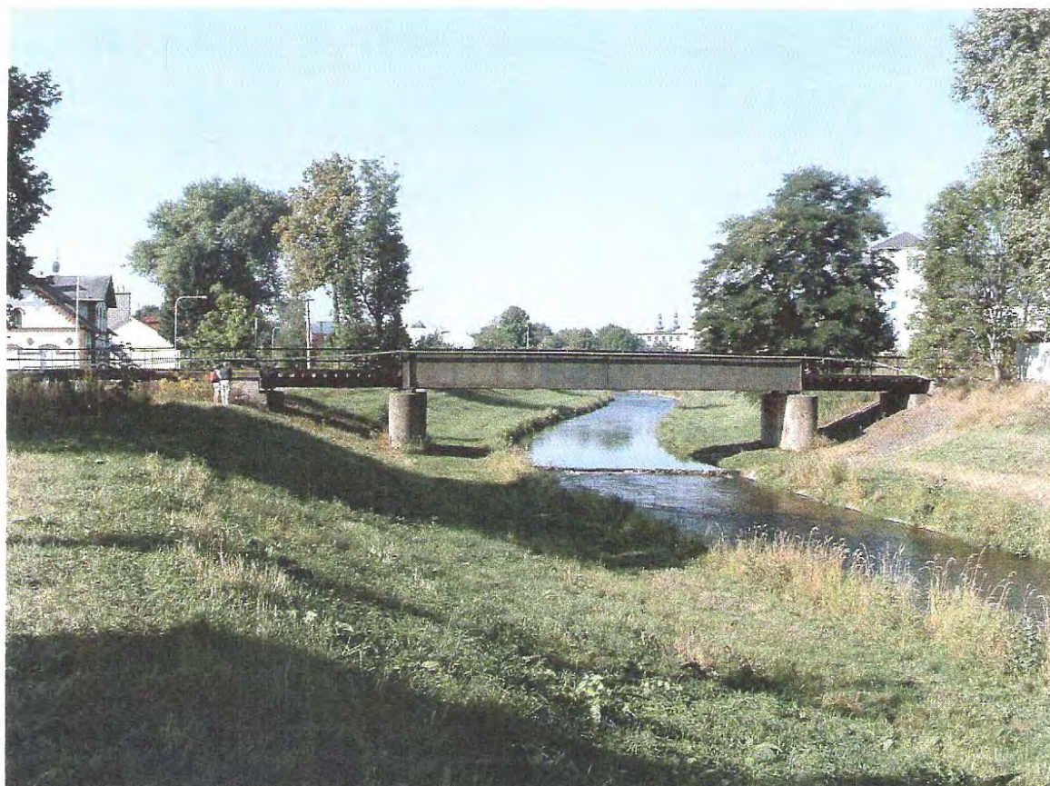
Obr. 1 Železniční most u nádraží
