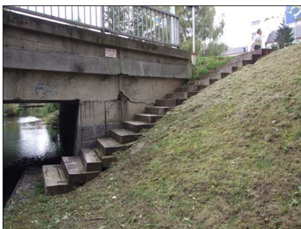
Obr. 3.26. Přístupy k vodě pomocí různě širokých schodišť vytvořených z různého materiálu - beton, dřevo (foto: Lukáš Krejčí, 2009)
