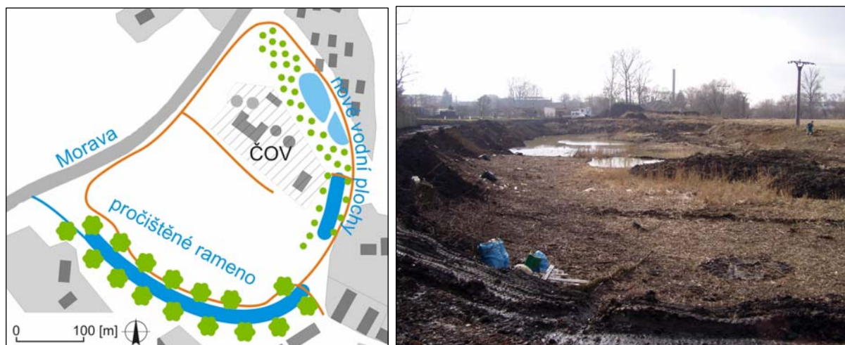
Obr. 3.54. Situace revitalizace odstaveného meandru Moravy a probíhající práce na pročištění koryta odstaveného ramene (foto: David Veselý, 2007)
