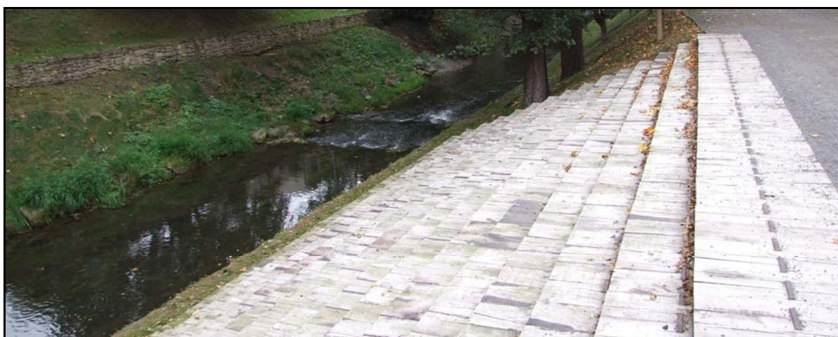
Obr. 3.30. Detail pobytového schodiště a vlastní tok Loučné s původními kamennými zídkami na levém břehu (Foto: Lukáš Krejčí, 2009).
