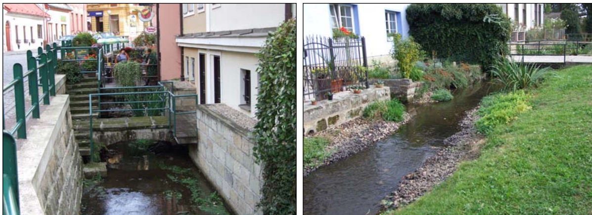
Obr. 3.9. Stísněné podmínky kamenného koryta v ulici Na Sádkách (vlevo) a esteticky hodnotná podoba koryta v ulici Koželužská (vpravo) (foto: Lukáš Krejčí, 2009)
