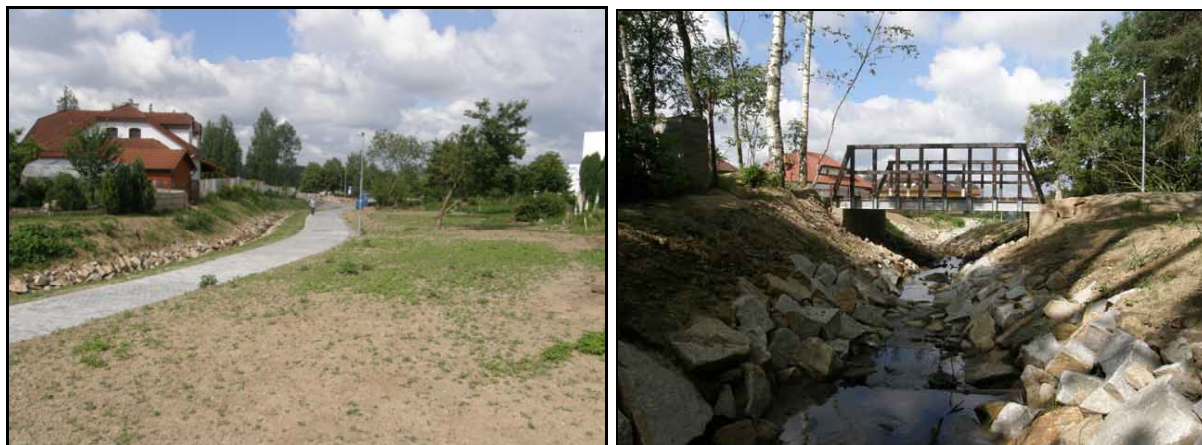
Obr. 3.2. Snímek vlevo znázorňuje území po revitalizaci - fotografie pořízena o něco níže po proudu než obrázek 3.1 vlevo, záběr vpravo ukazuje nově upravené koryto a jeho přemostění (foto: MěÚ Havlíčkův Brod, 2009)
