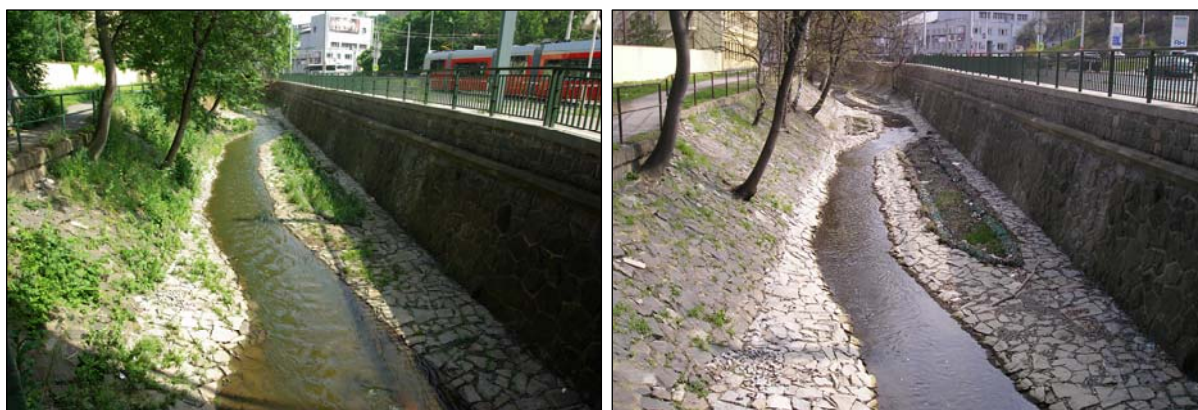
Obr. 3.45. Nově rozvlněná kyneta Botiče, pohled je z jednoho místa v různém vegetačním období; v pravé části jsou patrné osázené vegetační kazety (foto: Jiří Karnecki, 2008)
