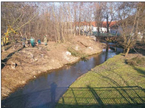
Obr. 3.40. Záběr vlevo - stav koryta a území před revitalizací. Z obrázků je patrné, že levý břeh Botiče je vlivem navážek výrazně vyšší (foto: Jiří Karnecki, 2009)
