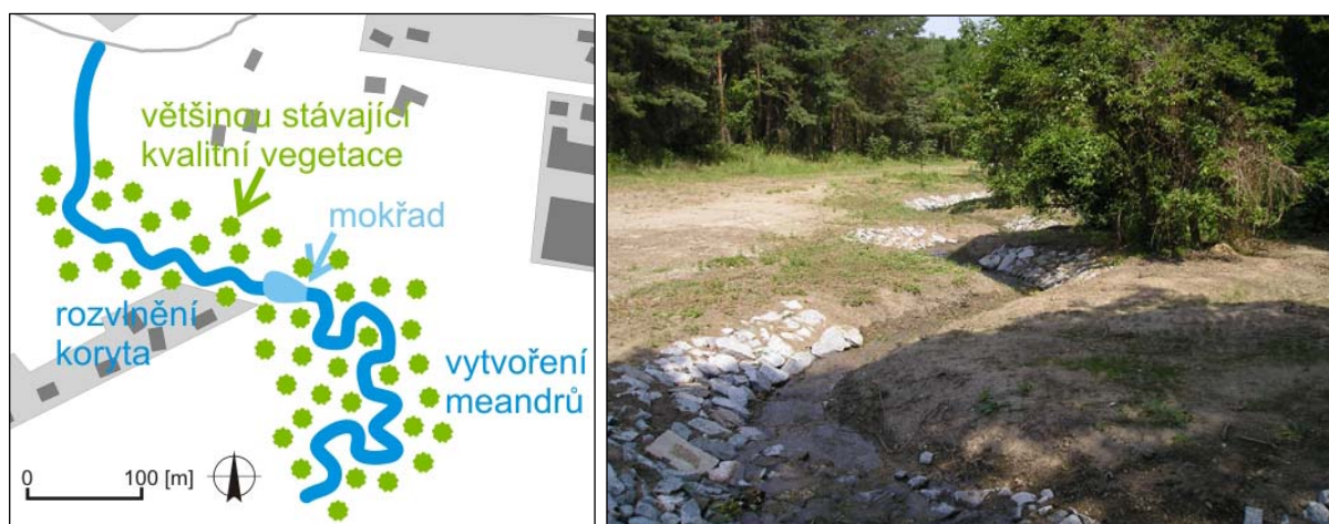
Obr. 3.47. Schematické znázornění revitalizace Krůteckého potoka; na záběru vpravo jsou viditelné čerstvě vymodelované meandry (foto: Jiří Karnecki, 2007)
