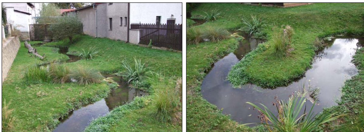
Obr. 3.11. Úsek revitalizovaného koryta v ulici Na Kopanici s meandry a rozmanitou vegetací (foto: Lukáš Krejčí, 2009)
