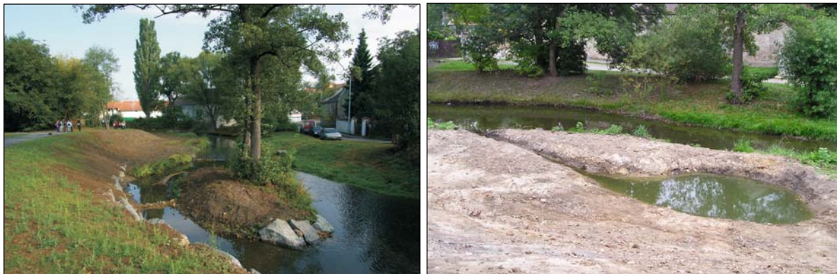
Obr. 3.41. Místní rozdvojení koryta Botiče (vlevo) a vytvoření tůňky na jedné z berem (vpravo) (foto: Jiří Karnecki, 2009)
