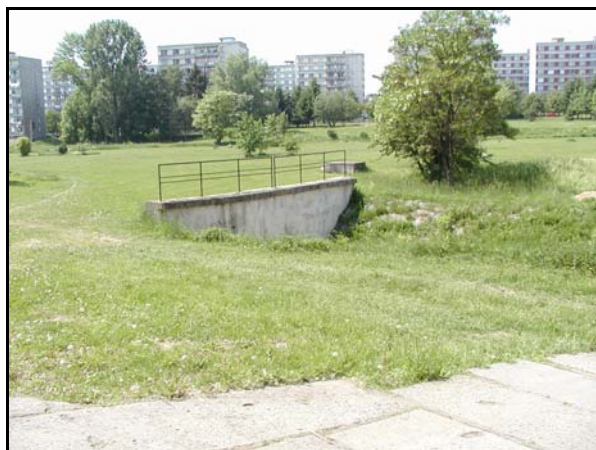
Obr. 3.13. Zatrubněné koryto zcela oddělené od celkově upravené nivy (foto: Šindlar, s.r.o., 2003) a rybník Šibeňák s hrází a přírodě blízkým bezpečnostním přelivem (foto MěÚ Jičín)
