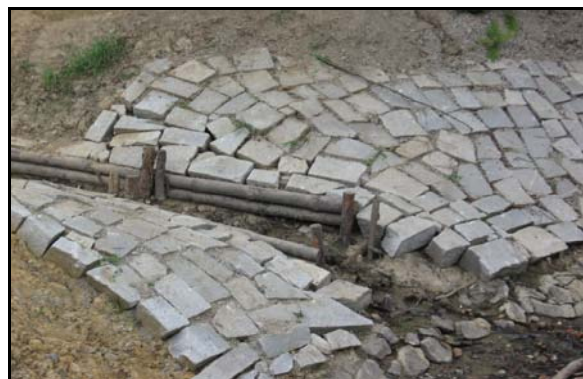
Obr. 2.7. Soutok Gurňáku (přítok vlevo) a Rychvaldské stružky po úpravě dolní části toku. Vpravo detail stavu opevnění koryta. (foto: Městský úřad Rychvald)
