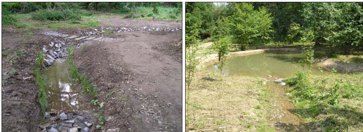
Obr. 3.48. Pohled na zvlněné koryto s přechodem pro pěší (vlevo). Na snímku vpravo je vybudovaná větší potoční tůň (foto: Jiří Karnecki, 2007).
