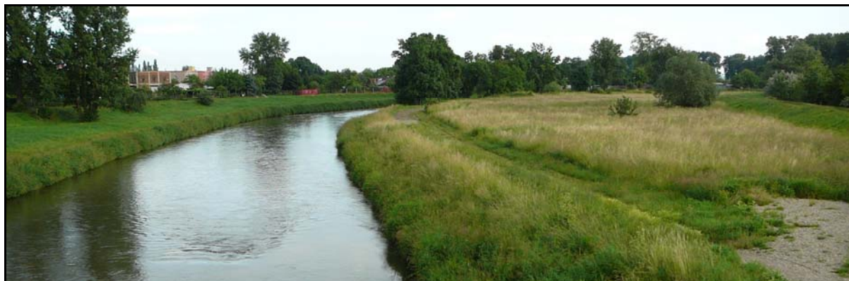
Obr. 3.36. Snímek řeky z mostu ul. Velkomoravské – pohled po toku (foto M. Krejčí, 2008)
