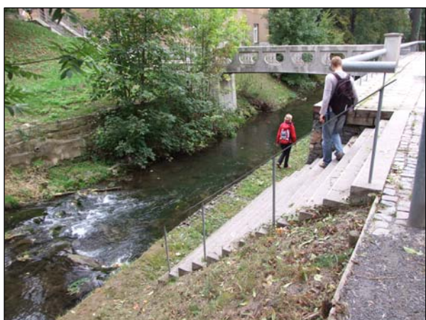
Obr. 3.26. Přístupy k vodě pomocí různě širokých schodišť vytvořených z různého materiálu - beton, dřevo (foto: Lukáš Krejčí, 2009)
