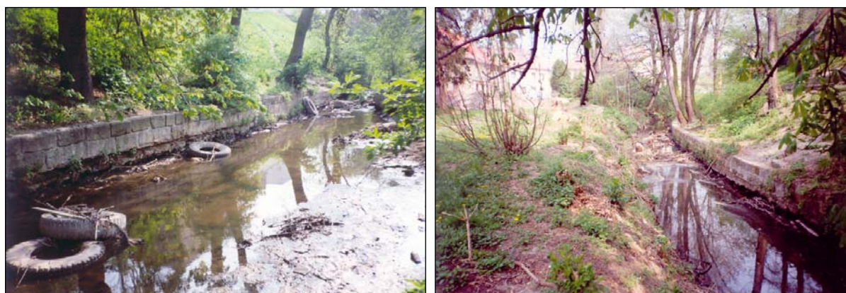
Obr. 3.5. Stav městského náhonu v místní části „U divadla“ před revitalizací (foto: Šindlar, s.r.o.)
