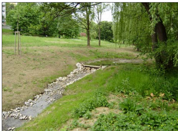
Obr. 3.51. Členité dno potoka ve formě kamenitých kaskád a tůní nad příčnými objekty po dokončení prací (foto: MěÚ Uherský Brod, 2009)
