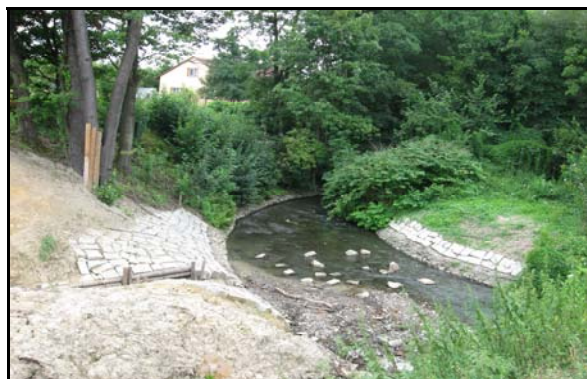
Obr. 2.7. Soutok Gurňáku (přítok vlevo) a Rychvaldské stružky po úpravě dolní části toku. Vpravo detail stavu opevnění koryta. (foto: Městský úřad Rychvald)
