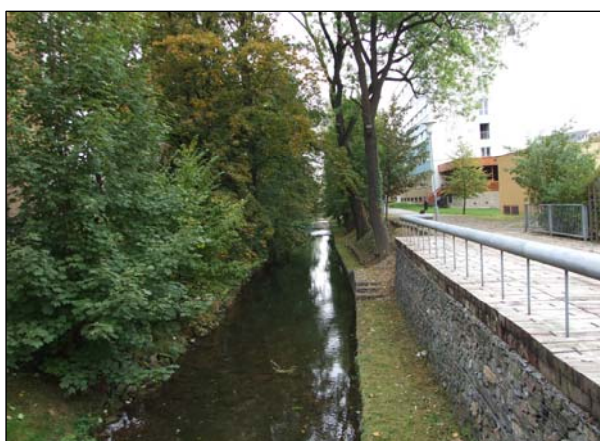
Obr. 3.25. Stezka pro pěší vedená v bermě pravého břehu v těsné blízkosti říční hladiny (foto: Lukáš Krejčí, 2009)
