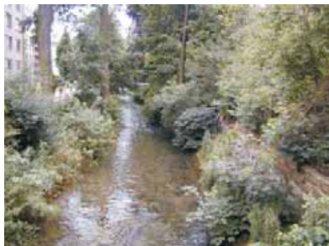
Obr.4 Stav před rekonstrukcí, 2001
