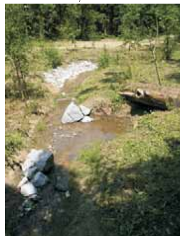
Obr.9 Koryto potoka během prací, 7/2007
