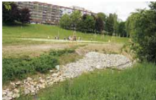
Obr.9 Nově tvarované koryto, 6/2009
