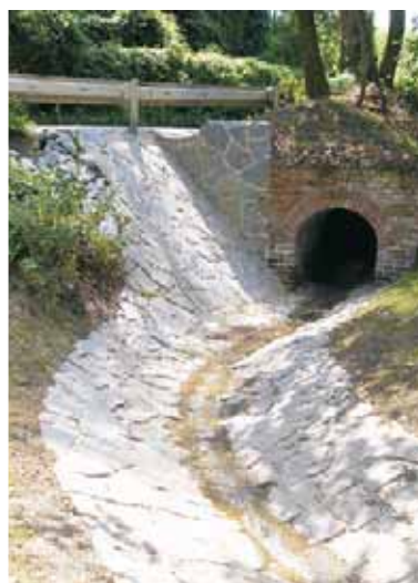
Obr.7 Stav silničního propustku po opravě, 7/2007
