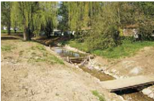
Obr.6 Nové úpravy koryta, 5/2009
