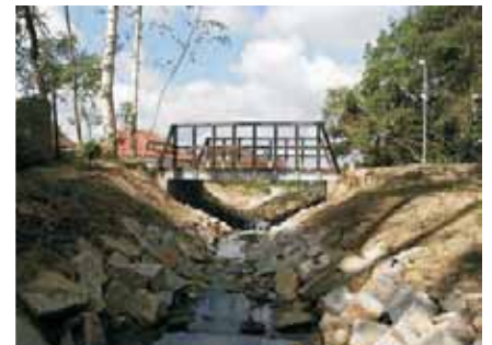
Obr.5 Po dokončení prací, 6/2009
