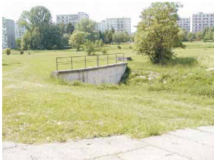
Obr.3 Stav před realizací - zatrubnění Valdického potoka, 5/2003
