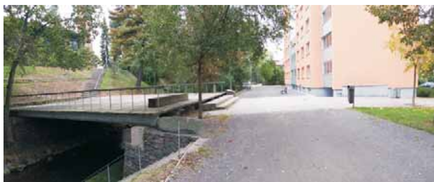
Obr. 2 Současný stav - pobytový mostek a schody k Music clubu Kotelna
