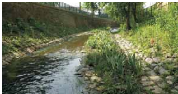
Obr.8 Rozvíjející se vegetace v korytě, 5/2008
