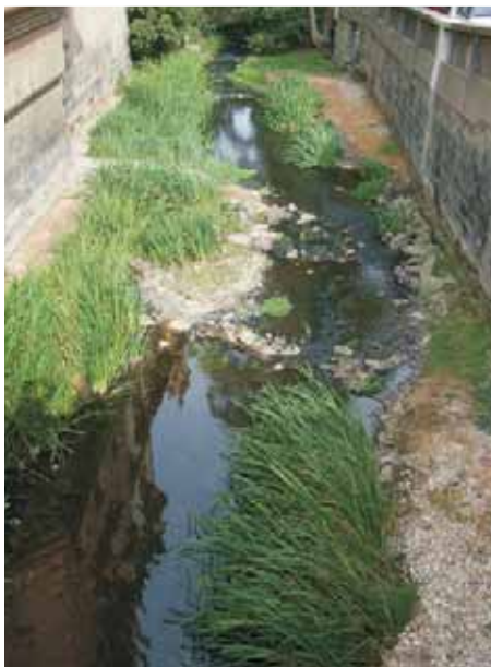
Obr.4 Revitalizovaný náhon mezi nábřežními zdmi, 10/2009
