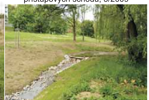
Obr.11 Stupňovité řešení podélného profilu, 6/2009
