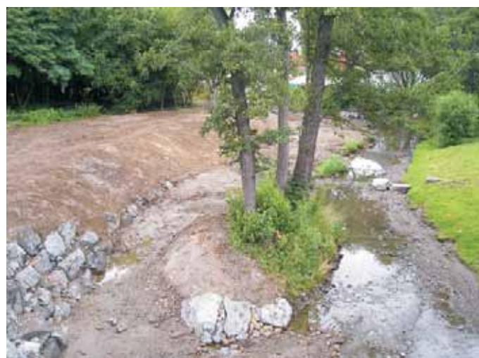
Obr.5 Rozdělení koryta a stabilizace kamenným záhozem, 7/2009
