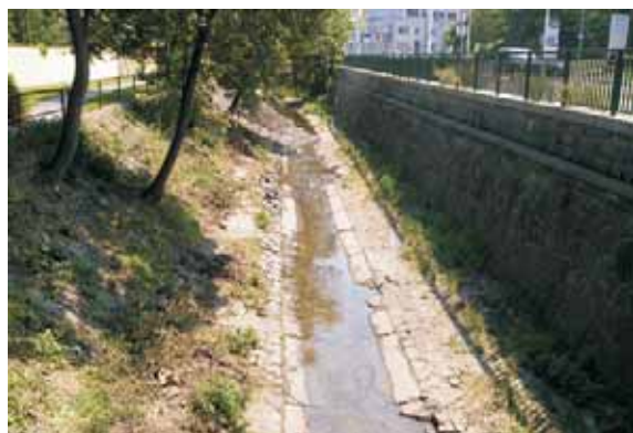
Obr.4 Stav před rekonstrukcí, 7/2007
