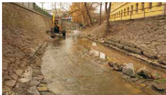
Obr.5 Opravy kamenného opevnění, 11/2007
