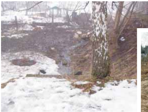
Obr.3 Stav toku před úpravou, 1/2009
