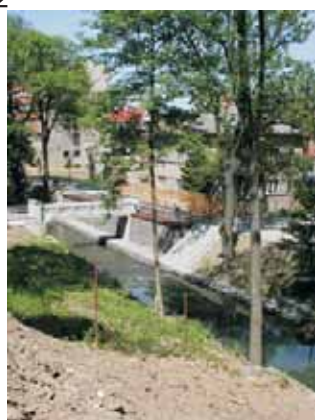
Obr.8 Stav po dokončení rekonstrukce, 5/2002
