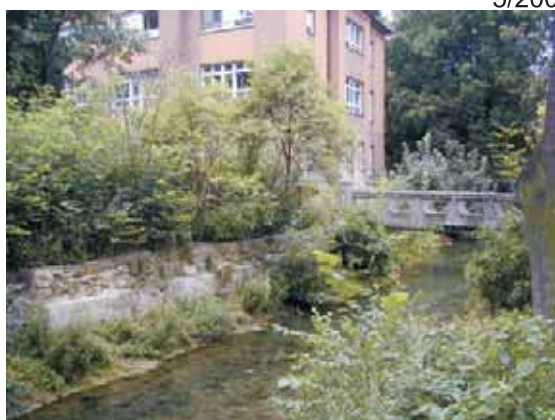
Obr.7 Stav před rekonstrukcí, 2001
