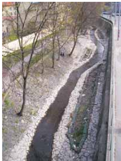
Obr.6 Nově rozvlněné koryto, 3/2008
