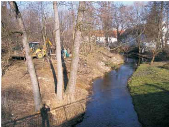
Obr.4 Úsek Botiče před revitalizací, 1/2009
