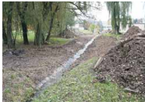
Obr.7 Během prací na revitalizaci, 6/2008
