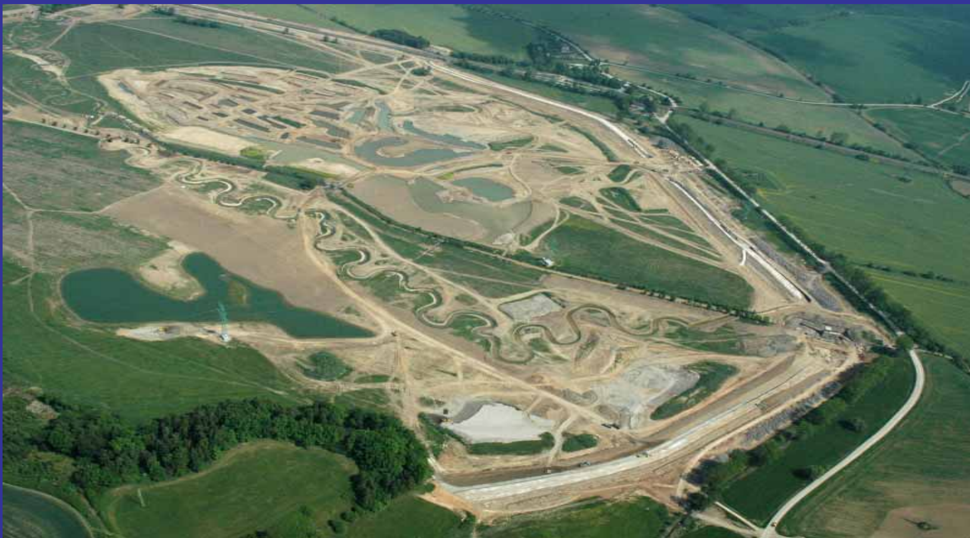
Revitalizace Moravské Sázavy a Lukovského potoka – Poldr Žichlínek Výstavba 2007
