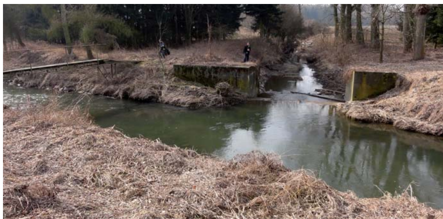
Přerozdělení průtoků Oskavy na jezu Zamykalka
