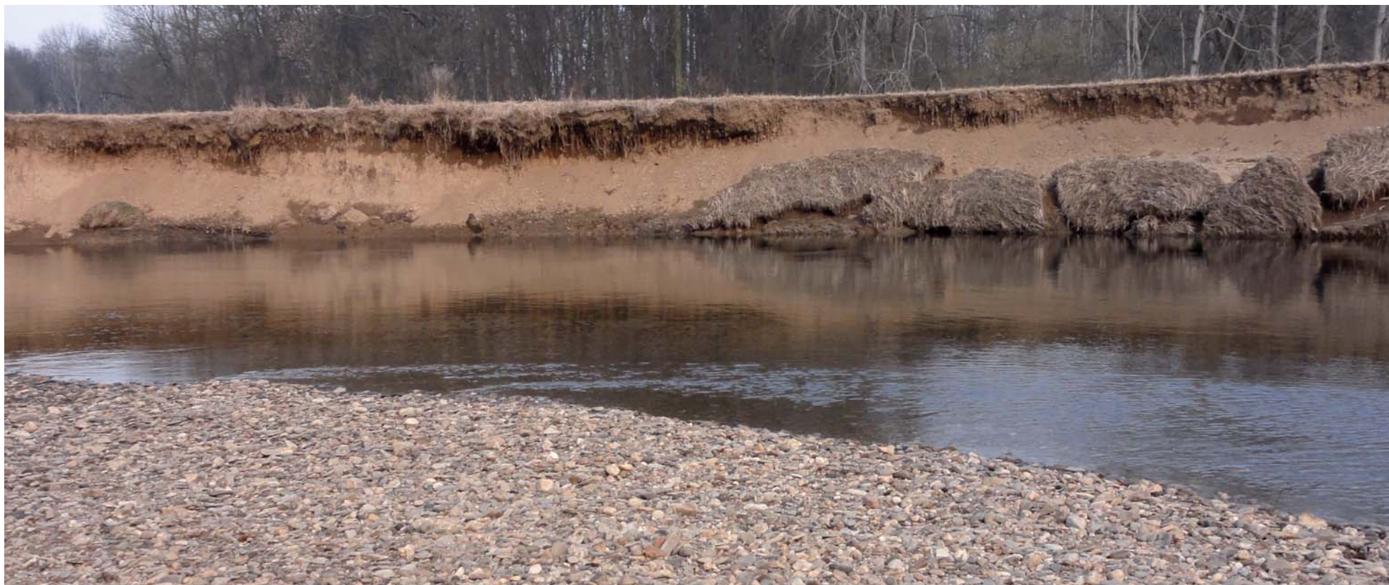
Morava s živým vývojem koryta je vzorem pro renaturalizaci řeky u Štěpánova (max. průměrný posun výsepního břehu je 0,5 m/rok)
