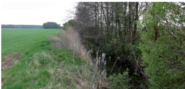
Náletový břehový porost je omezen na svahy zahloubeného koryta, břeh vlevo s uloženými sedimenty po dřívějším čištění toku
