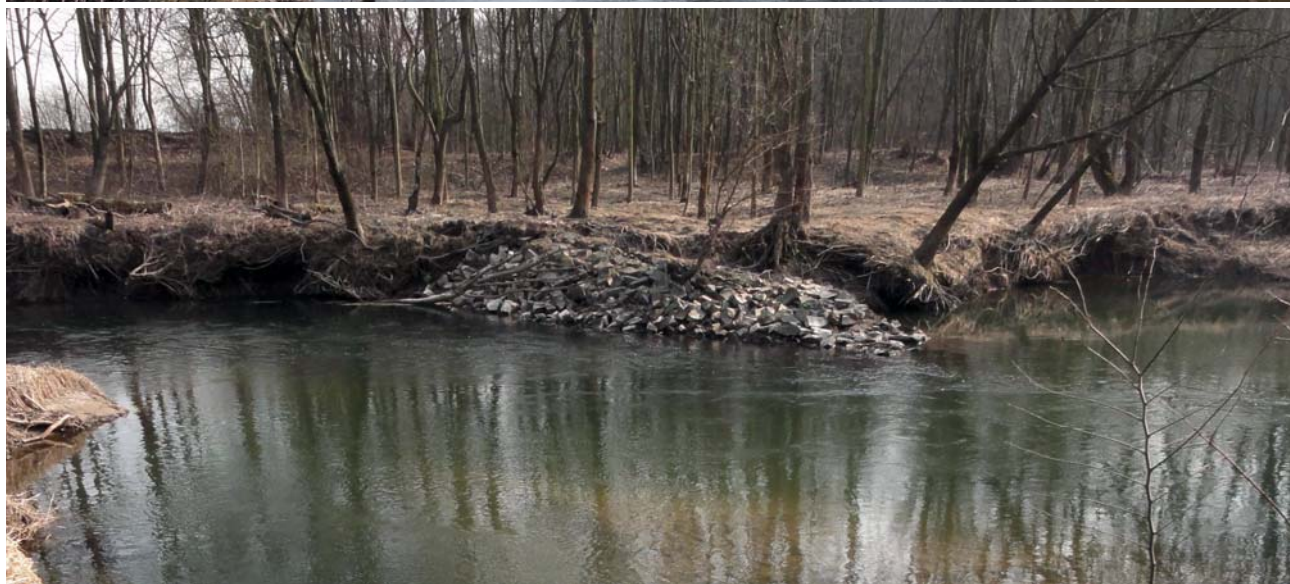
Řeka Morava – stávající kamenný výhon na levém břehu vychýlil trasu toku a vytvořil velmi hlubokou tůň a za ní mělký brodový úsek s postranním šterkovým náplavem (náplav není na fotografiích zachycen). Příklad možného diverzifikačního prvku pro renaturalizaci Moravy
