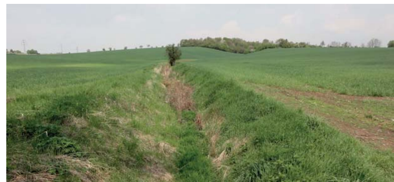
Meliorovaný přítok Benkovského potoka v podobě hlubokého příkopu, do kterého ústí plošné odvodnění z okolních polí...
