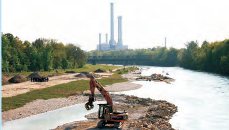
Práce v jednom z úseků Isary ve středu města, 2008; rozšiřování a rozvolňování kynety
