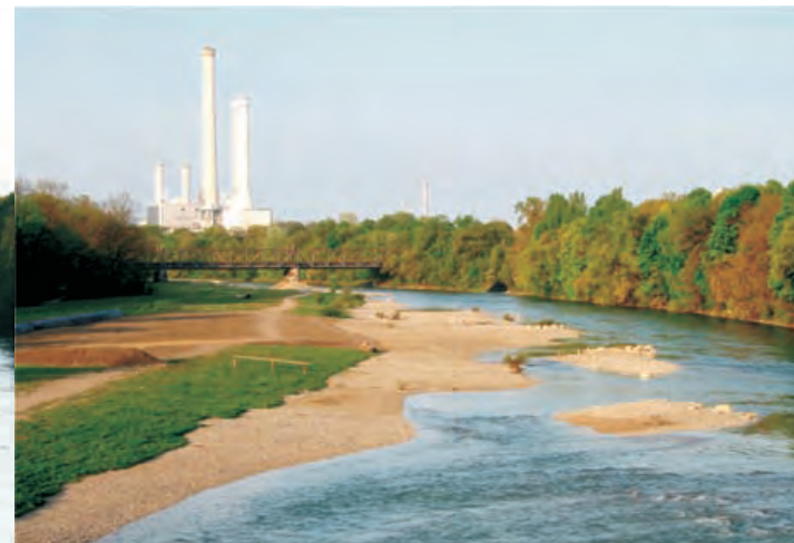
Úsek z předcházejícího obrázku po dokončení výstavby, jaro 2009
