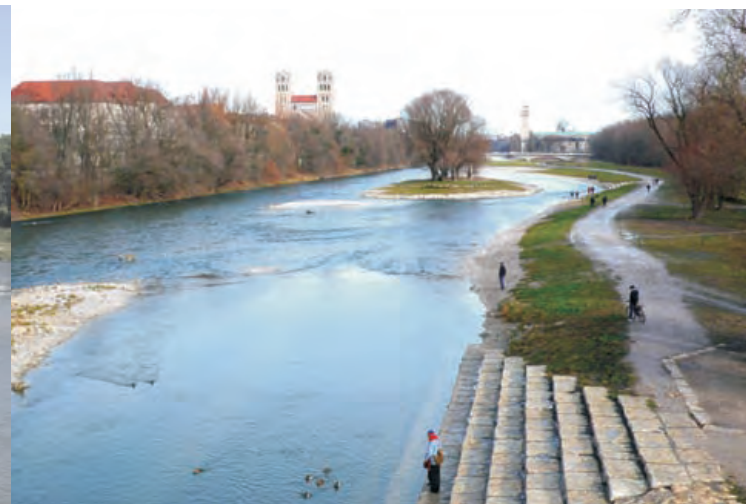
Předposlední úsek revitalizace po dokončení prací, podzim 2009; uprostřed Vrbový ostrov, vzadu budovy Deutsches Museum
