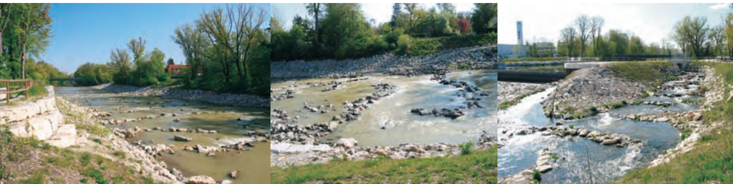
Vlevo: Dnová rampa postavená ve dně řečiště v místech, kde byl v roce 2006 stržen jez Goggeles (pohled v roce 2007) Uprostřed: Detail tvarování dnové rampy v místech bývalého jezu Goggeles za malého průtoku Vpravo: Ackermannův jez v rozmezí 1. a 2. projektového úseku, zrekonstruovaný v roce 2006. Pohled na nový rybí přechod
