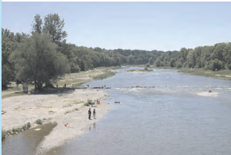
Jeden ze starších úseků na jižním okraji Mnichova; rozvolněná kyneta, štěrkové lavice, ostrov, dnová rampa z balvanů
