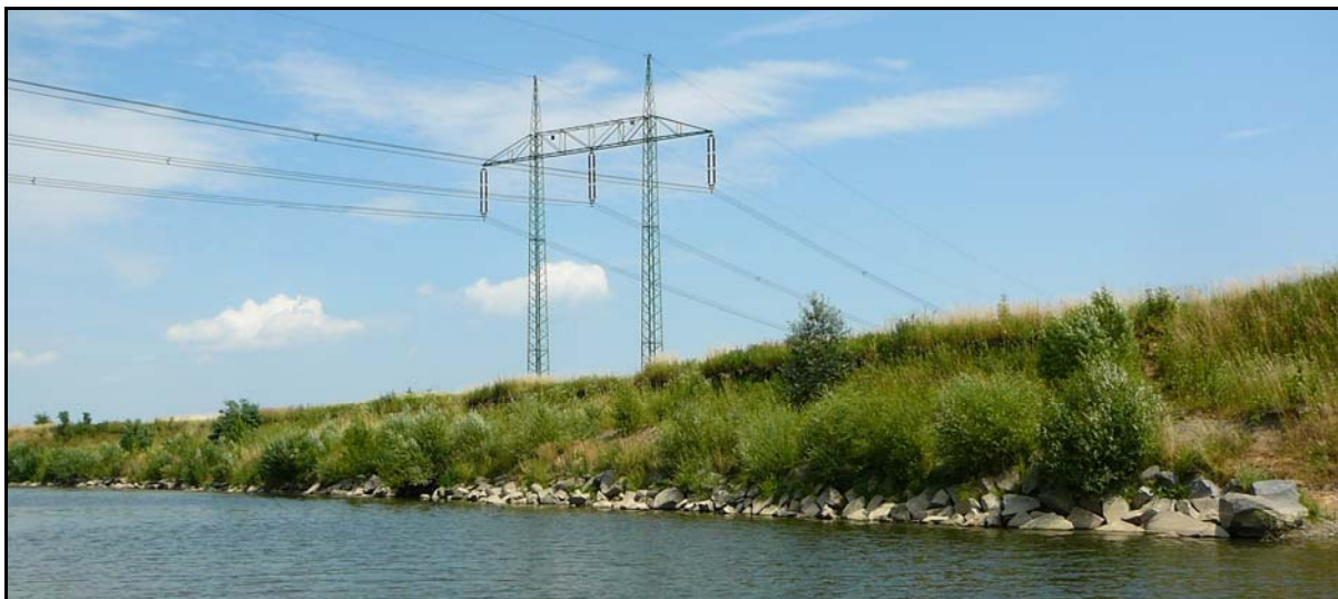
Foto 32) Osecká Bečva – podélné opevnění břehu kamennou rovnalinou v délce 250 m realizováno z důvodu ochrany stožáru VVN v r. 2003 v horní části zpřírodněného úseku. Aktuálně se pro zabezpečení linky VVN ve střední části úseku (viz foto 30 a 31) projektují přírodě blízké renaturační prvky – břehové výhony a středové rozražeče, jež dočasně stabilizují předmětnou část výsepního břehu a přitom nezhorší celkový hydromorfologický stav lokality (případné negativní efekty budou kompenzovány přímo v rámci akce jinými biotechnickými prvky (např. objekty z mrtvého dřeva podporující tvorbu štěrkových náplavů))
