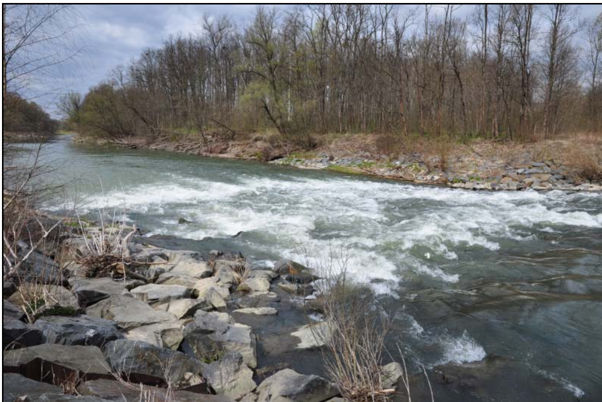
Foto 51) Balvanitý skluz pod ústím Juhyně – na toku Bečvy je novodobě vybudována řada těchto objektů, jejich stavba byla vyvolána stále probíhající erozí dna (zahlubování koryta)
