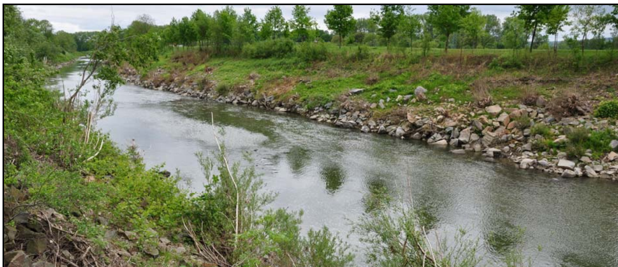
Foto 5) Rovněž v regulovaných úsecích Bečvy probíhá eroze. Nikoliv boční (břehová) s vývojem trasy toku, ale hloubková (dnová). Přehloubené koryto pod stupněm Osek n/B. Břehové erozi (i sesouvání svahů) brání opevnění, které je nutno stále doplňovat a opravovat
