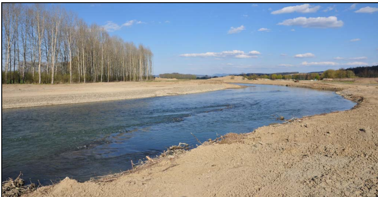
Foto 63) Revitalizační úprava Bečvy u Černotína a Skaličky – příklad přírodě blízkého protipovodňového opatření, jež spočívá v revitalizační úpravě toku s širokými bermami
