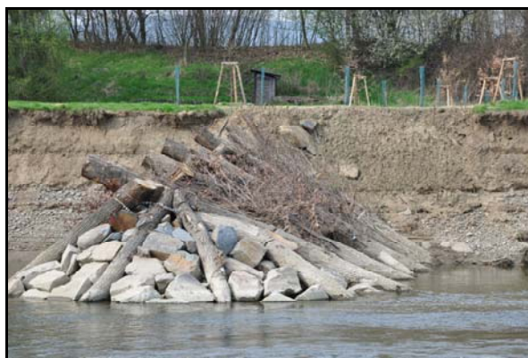
Foto 14 a 15) Bečva u Famílie – pohled na břehové výhony ze dřeva a kamene, jež byly vybudovány na podzim 2012 (foceno duben 2013)
