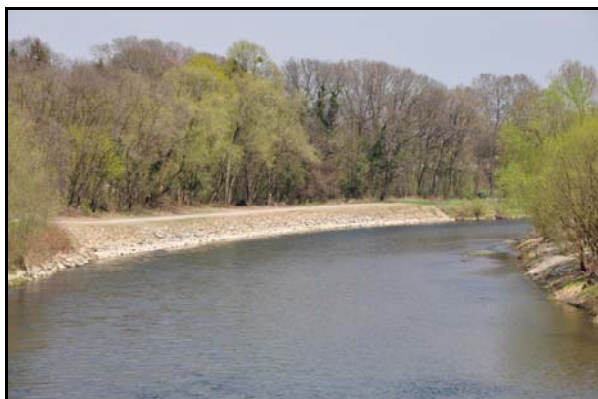
Foto 3 a 4) Regulované úseky toku vyžadují neustálou údržbu, opravy a rekonstrukce. Nově opevňované břehy Bečvy najdeme i v dnešní době (ilustrační záběry od Lipníku n/B)
