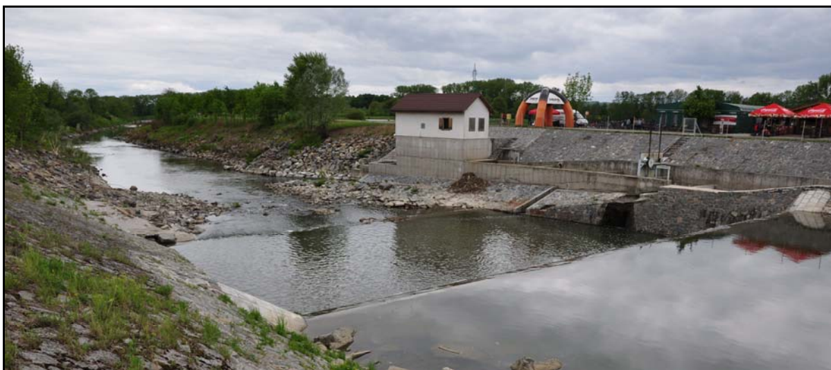
Foto 41) Pevný stupeň Osek n/B. s nefunkčním rybochodem – třetí bariéra (ř. km 24,250)
