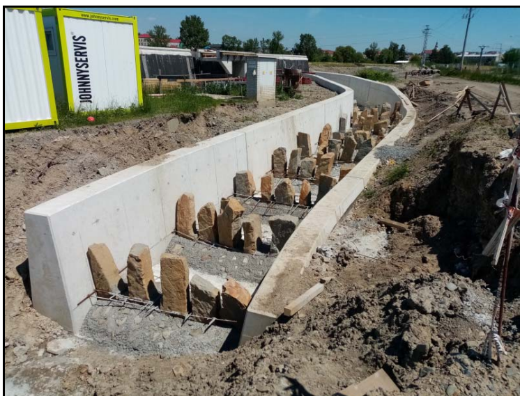
Foto 44 a 45) Pohyblivý jez Hranice – stavba rybího přechodu formou levobřežního obtoku
