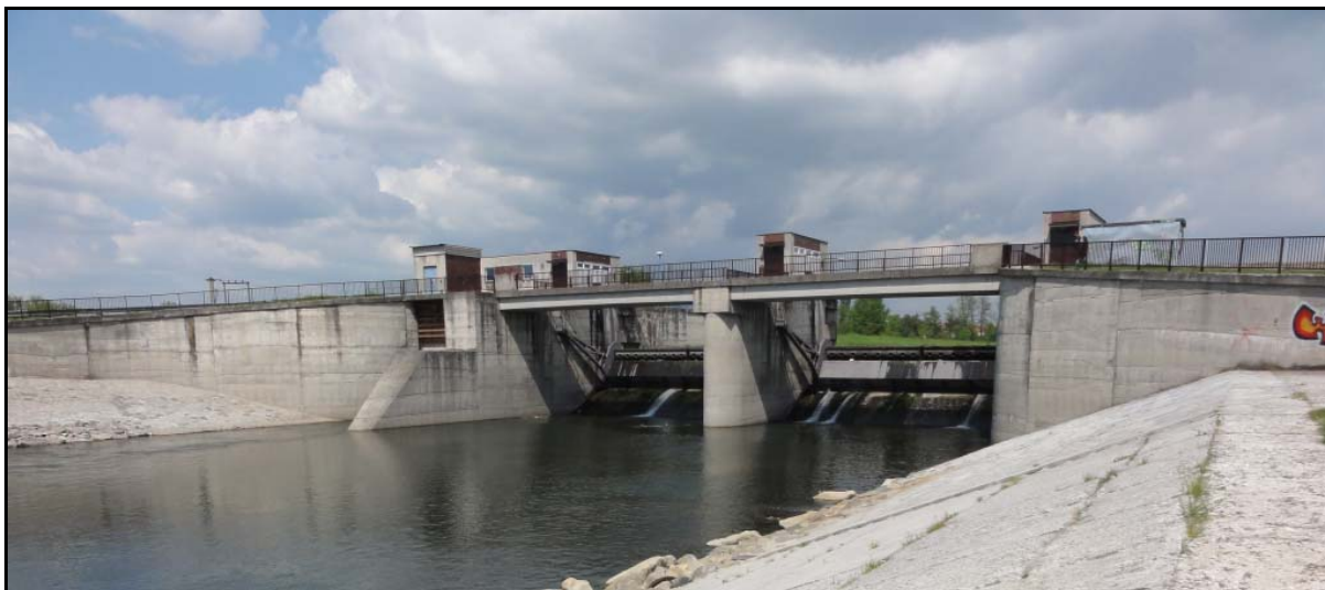
Foto 43) Pohyblivý jez Hranice – v současnosti probíhá přístavba třetího jezového pole a v souvislosti s rekonstrukcí objektu (ř. km 36,440) i stavba rybího přechodu, který je řešen levobřežním obtokem o délce 145,05 m. Rybí přechod překonává spád o výšce 5,10 m, a to ve sklonu 3,9 % u přírodní části rybochodu a 3,33 % u technického koryta, a to pomocí 49 kamenných přehrázek. Rychlost proudu ve štěrbinách mezi kameny bude činit cca 1 m/s
