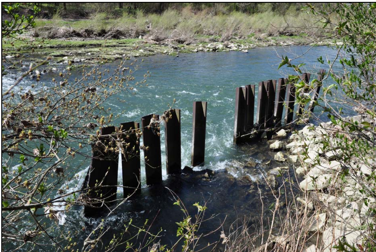
Foto 19) Bečva pod Choryní – renaturace horního úseku (ř. km 54,60 - 55,10), pohled na již nefunkční larsenovou stěnu, kterou lze využít pro založení středového rozražeče
