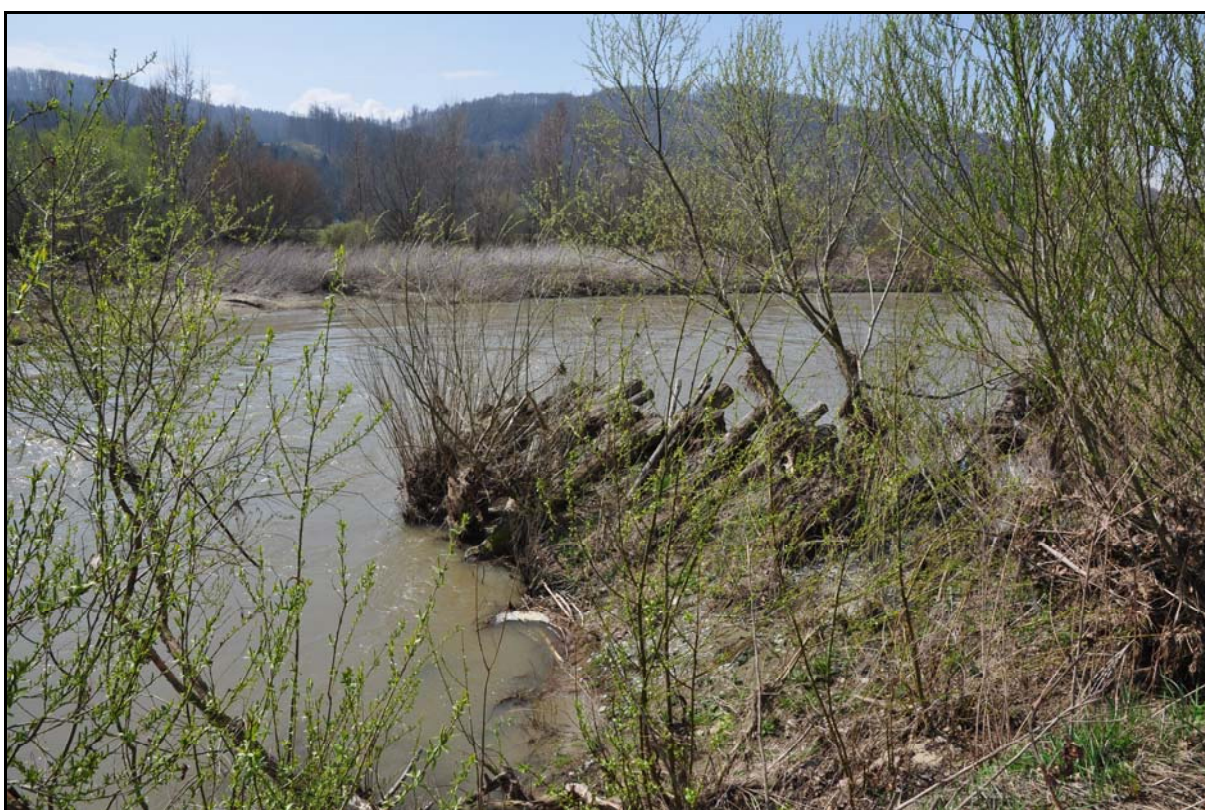
Foto 14 a 15) Bečva u Famílie – pohled na břehové výhony ze dřeva a kamene, jež byly vybudovány na podzim 2012 (foceno duben 2013)
