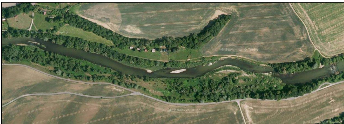
Obr. 13) Bečva u Familie – letecký snímek z 6. 5. 2018 s horní částí zájmového úseku toku (tzv. Zadní Familie). Úsek toku je stabilní, neboť na Bečvě se od povodně 2010 nevyskytly povodňové stavy. Výsepní břeh částečně zarůstá vegetací, a to i v horní neopevněné trati
