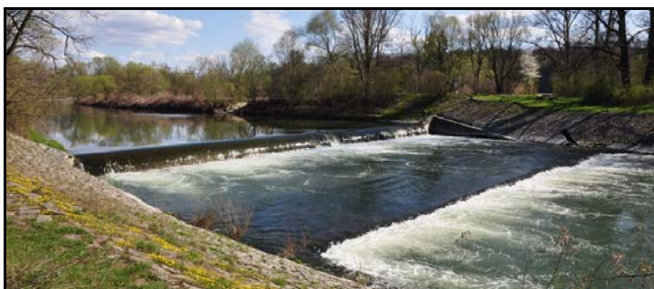
Foto 46 a 47) Parabolický jez Juřinka I – pátá migrační bariéra na Bečvě (ř. km 58,1). Pro její zprostupnění lze vedle rybí rampy zvažovat i snížení výšky stupně a přestavbu na skluz
