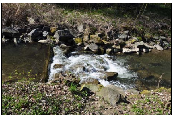
Foto 61 a 62) Loučka – ústí přítoku do Bečvy u Valašského Meziříčí. Strmý balvanitý skluz vytváří zbytečnou migrační bariéru ve výústní trase Loučky. Navrhuje se dosypání skluzu v mírném sklonu, a to jak po proudu, tak i proti němu. Vlastní ústí Loučky v délce cca 10 m bude ponecháno jako refugium s lákavým proudem
