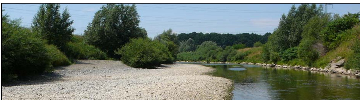
Foto 34) Osecká Bečva – návrh na odstranění panelů a vytvoření iniciační břehové nátrže
