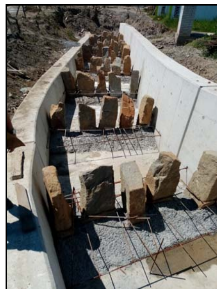
Foto 44 a 45) Pohyblivý jez Hranice – stavba rybího přechodu formou levobřežního obtoku
