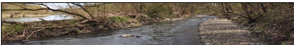
Foto 58) Juhyně – ústí přítoku do Bečvy u obce Choryně se soutokovým výběžkem
