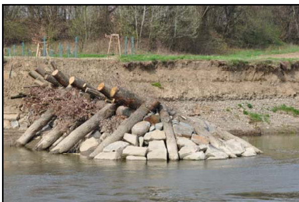
Foto 14 a 15) Bečva u Famílie – pohled na břehové výhony ze dřeva a kamene, jež byly vybudovány na podzim 2012 (foceno duben 2013)
