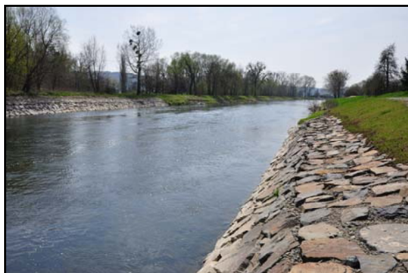
Foto 3 a 4) Regulované úseky toku vyžadují neustálou údržbu, opravy a rekonstrukce. Nově opevňované břehy Bečvy najdeme i v dnešní době (ilustrační záběry od Lipníku n/B)
